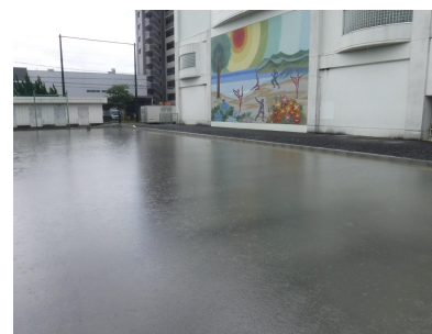
雨水貯留浸透施設の様相 (豊田中学校 令和3年8月撮影)
